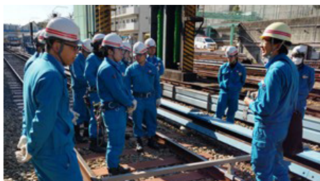
サードレール復旧訓練
