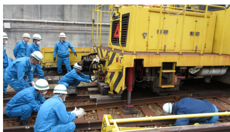
軌道モーターカーの脱線復旧訓練
