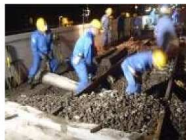
PC まくらぎ更新作業風景
